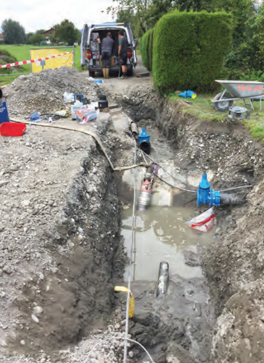
Tiefbauarbeiten für die Wasserversorgung und für die Kanalisation in Fußach.
